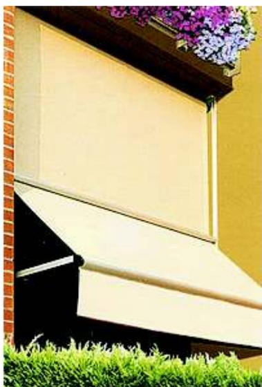
Terrazzo coperto della zona giorno attrezzato con tende esterne a caduta della ditta BRIANZA TENDE modello T49 funzionante a motore con scorrimento del telo in guide di alluminio verticali e tenda a bracci motorizzati modello R30 Mistral. Finitura telo colore avorio.
